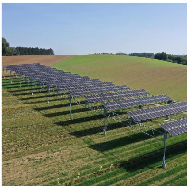
Abbildung 3: Pilotprojekt Agri-Photovoltaik-Anlage in Heggelbach am Bodensee. Bild: Fraunhofer ISE, <https://www.ise.fraunhofer.de/de/leitthemen/integrierte-photovoltaik/agri-photovoltaik-agri-pv.html> (08.04.2022)
