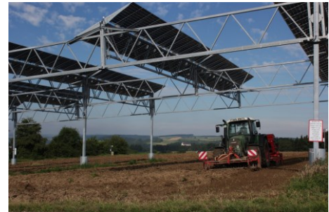
Abbildung 1: Agri-PV-Anlage in Heggelbach, Bild: Fraunhofer ISE
